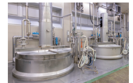
エキス混合タンク
